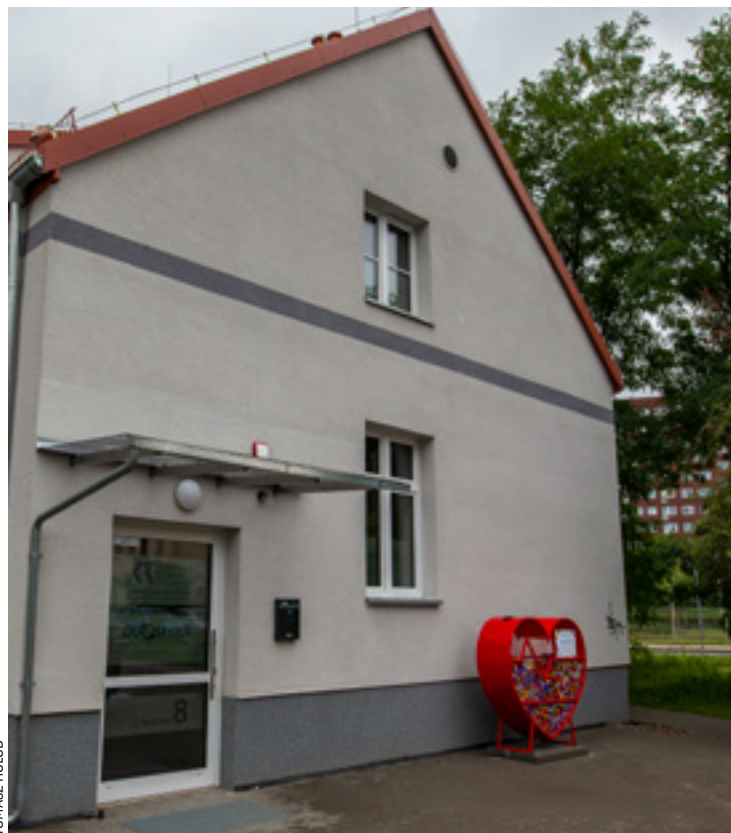
Wyremontowana siedziba RO Karłowice-Różanka przy ul. Bałtyckiej
